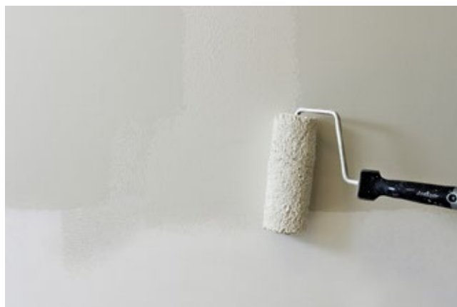
2. Begynn med veggens øverste del, mal to strøk med rull, og mal litt lengre ned enn kanten skal være. (Jotun 486 Silke)
