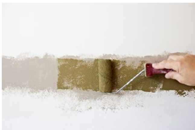
5. Mal veggens nederste del (Jotun 8420 Oliventre). Bruk liten rull øverst.
